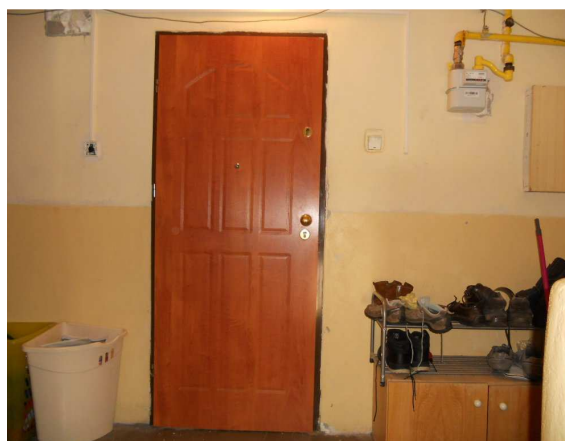
Vchod do bytu
